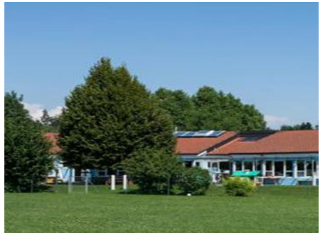
Außenansicht des Kindergartens
