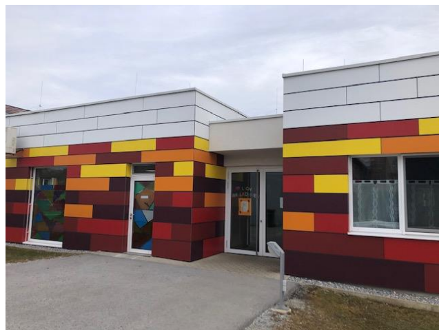
Außenansicht des Kindergartens
