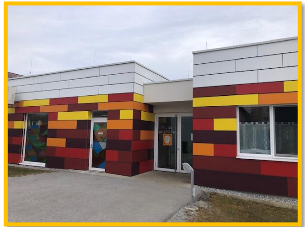
Außenansicht des Kindergartens
